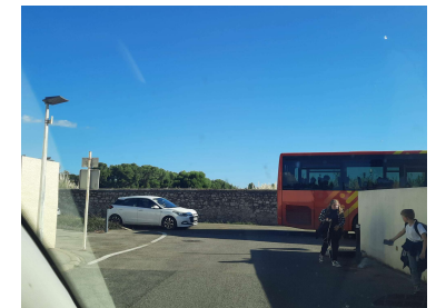
Carrefour av de la Gare – rue des Mouettes : un aménagement viaire peu sécurisé pour les usagers des transports en commun (scolaires)
