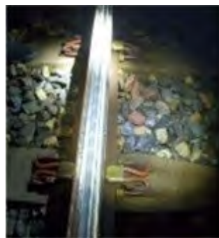
Rail après meulage
