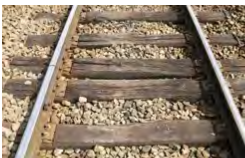
Rails courts sur traverses bois
